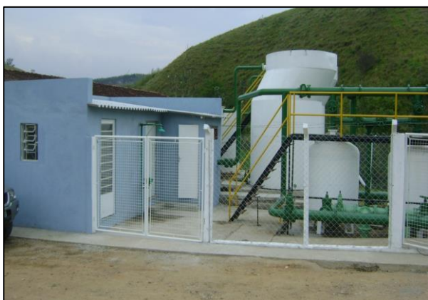
Figura 30 – Acesso a ETA Engenheiro Passos
