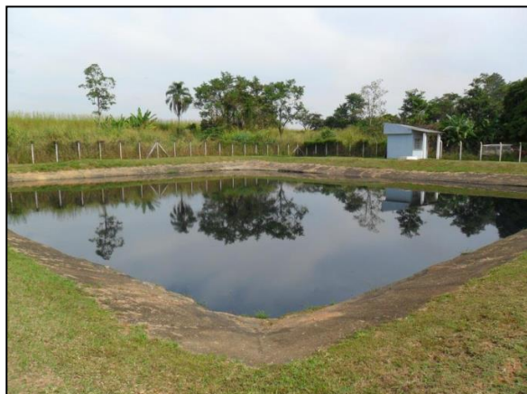
Figura 61– Lagoa anaeróbia da ETE Isaac Politi
