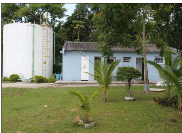
Figura 23 – Vista da ETA São Caetano
