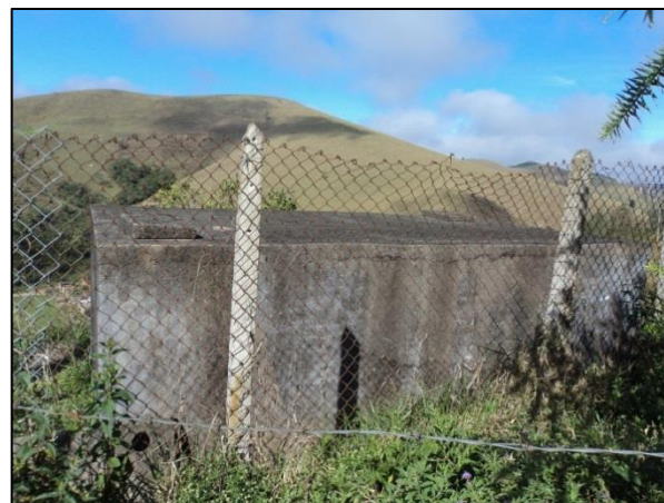
Figura 36 – Reservatório do distrito de Fumaça
