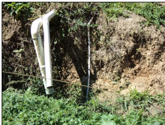
Figura 70 – Lançamento do esgoto da localidade de Rio Preto
