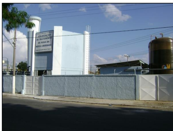
Figura 7 – ETA Nova Liberdade
