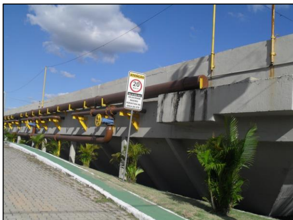
Figura 58– Vista da estrutura da ETE Alegria.
