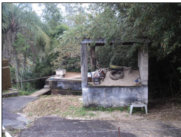
Figura 32 – Sistema de filtração e reservação do distrito de Pedra Selada
