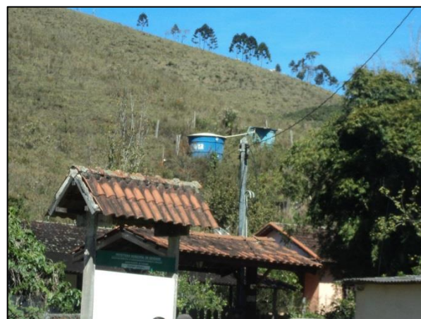
Figura 42 – Vista das unidades de reservação
