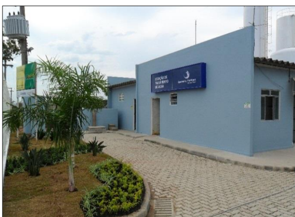
Figura 20 – ETA Fazenda da Barra
