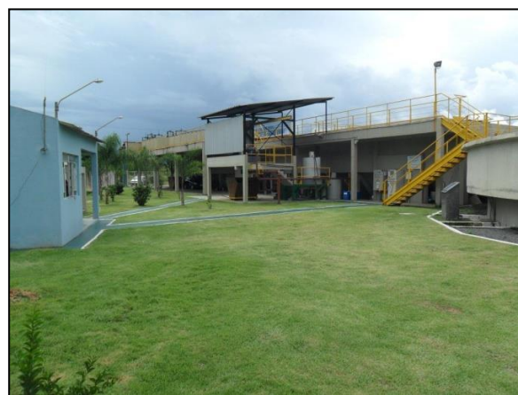
Figura 55 – Vista da ETE Alegria
